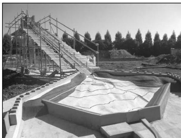
写真 1 模型完成状況（下流より撮影）
