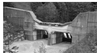
写真-6 屈曲部のある水通し断面
