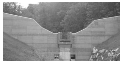
写真-7 切欠き部を設けた水通し断面
