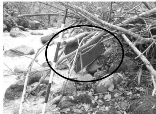
写真 5 流出した充填材（上山沢第 1）
