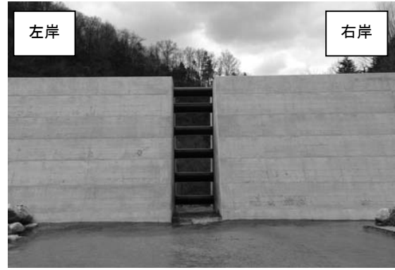
写真 4 上山沢第 1 砂防堰堤（改修後）
