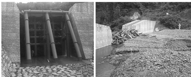
写真1 平野川堰堤の捕捉状況
