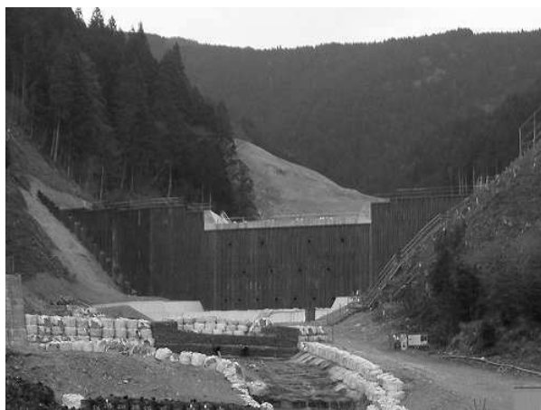
写真-2 スライド式二重鋼矢板基礎工付き INSEM-DW 施工例(北股地区)
