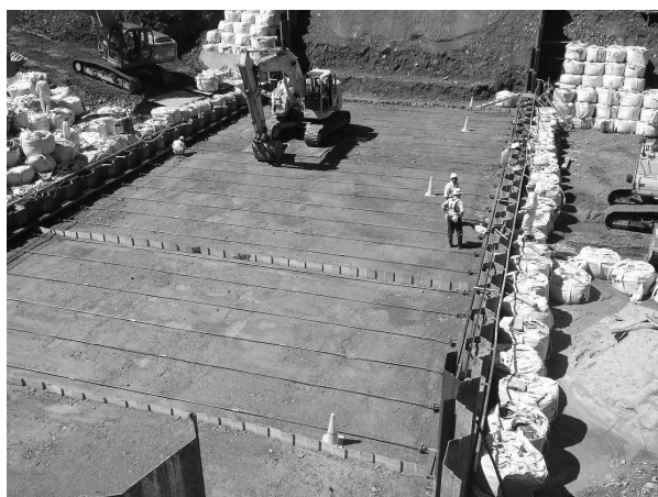
写真-1 スライド式二重鋼矢板基礎施工状況
