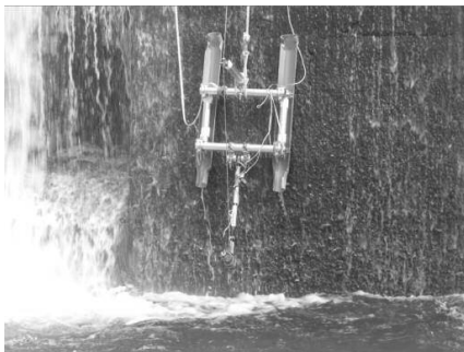
図 4 堰堤下流面における起振状況
