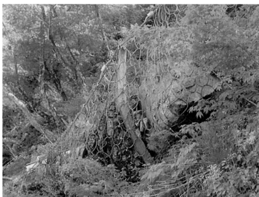
図-1 高エネルギー吸収柵で捕捉された落石事例
