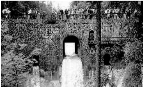
筏流しのために設置された水門付き堰
