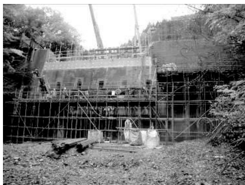
写真-1 施工状況
