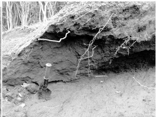
図 2 源頭部崩壊のすべり面付近。黄色火山灰層の上の黒色火山灰層がすべった。
