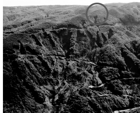
図 1 斜面崩壊領域全景と調査対象斜面位置
