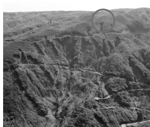
図 1 斜面崩壊領域全景と調査対象斜面位置 (○印箇所)
