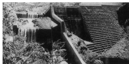
白岩砂防堰堤(1939年(昭和14年)完成)
