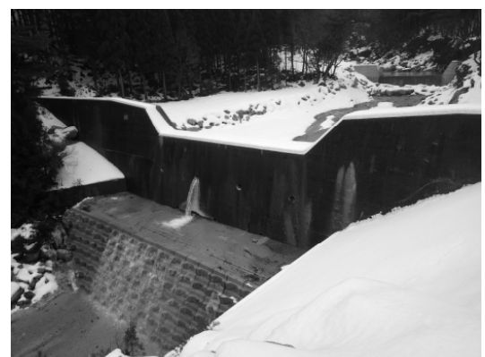
写真-3 補修後谷止工全景
