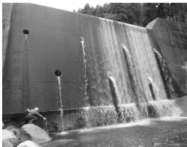
写真-1 谷止工のつま先洗掘状況
