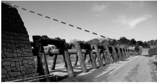
写真-3 上流側除木後状況
