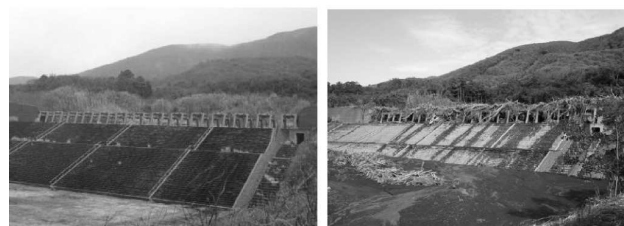
(a) 災害発生前 (b) 災害発生後 写真-2 大金沢本川の土石流・流木捕捉状況 (B型)
