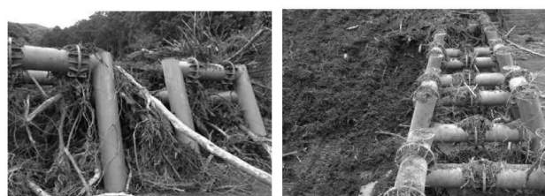
(a) 災害発生後 (b) 除石・除木時 写真-3 大金沢支川の除石・除木状況 (B型)
