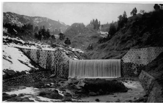
図-2 建設当時の鎌倉沢川 8 号堰堤工(昭和 11 年撮影) 3)
