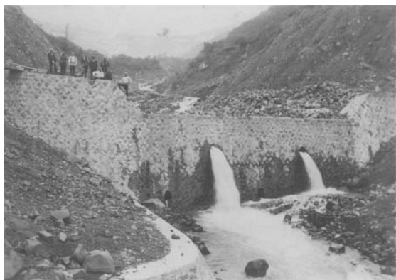
図-1 竣工直後の万内川一号堰堤(大正 13 年撮影)
