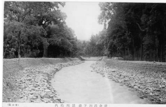
図-3 鎌倉沢川砂防流路工(昭和 11 年撮影) 3)
