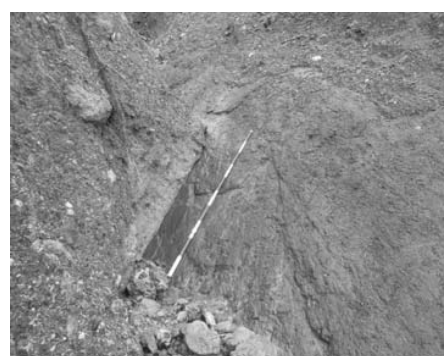
写真-3 難透水層上の流水状況
