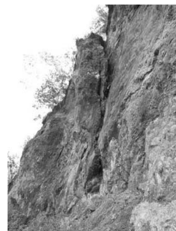
写真-2 断層と露岩の剥離状況
