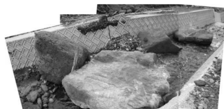
写真-1 流路内の巨礫の停止状況
