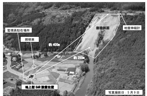
図-2 斜面監視機器等の配置
