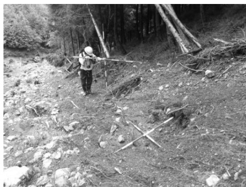
写真-2 土石流流下部に見られる引きちぎられた樹根や傾倒木(須佐大橋東側流域の崩壊)
