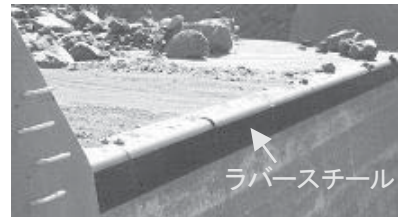
写真-2 水通し天端の設置事例
