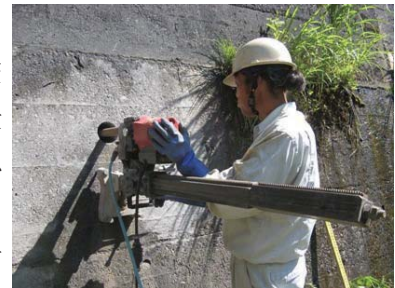
写真2. コアサンプリング状況
