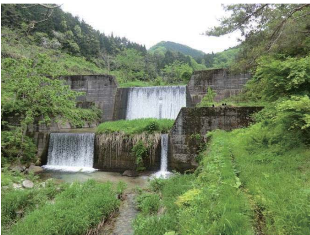
写真1. 品又谷第1砂防堰堤
