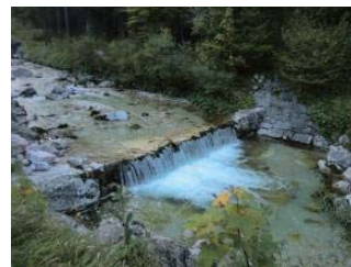
図3 ラングバートバッハの床固め工(オーストリア)
