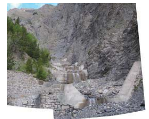
図4 サニエル溪谷の砂防堰堤(フランス)
