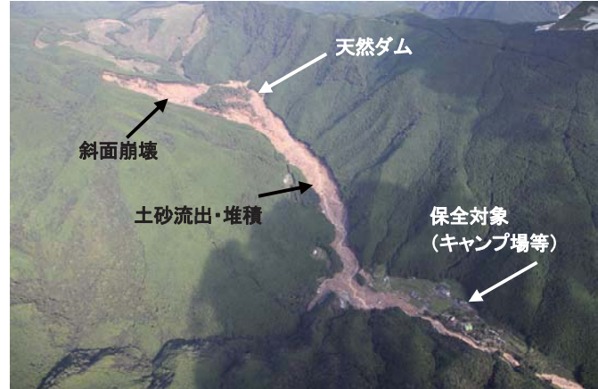
写真-1 熊野地区斜面崩壊・土砂流出状況
