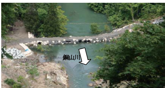
写真-2 渡河施設全景
