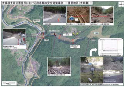
事例-1 大規模崩壊箇所における出水期の安全対策事例（奈良県）
