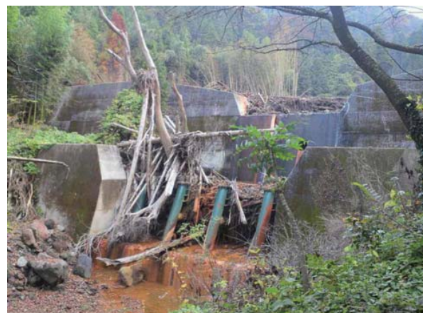
写真1 土砂・流木の捕捉状況 (塩井川2堰堤)
