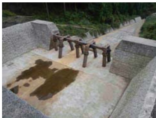
除石・除木の状況
