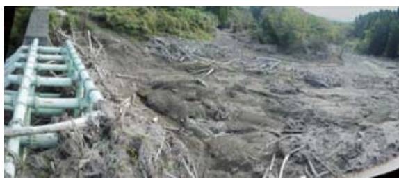
上流側の状況
