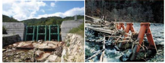
写真-1 透過型砂防堰堤
