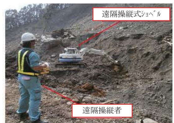
写真-3 無人化施工状況：清水地区 3)
