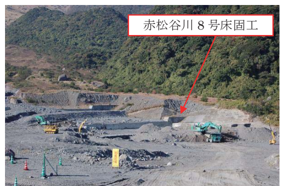
写真-1 赤松谷川8号床固工の施工状況
