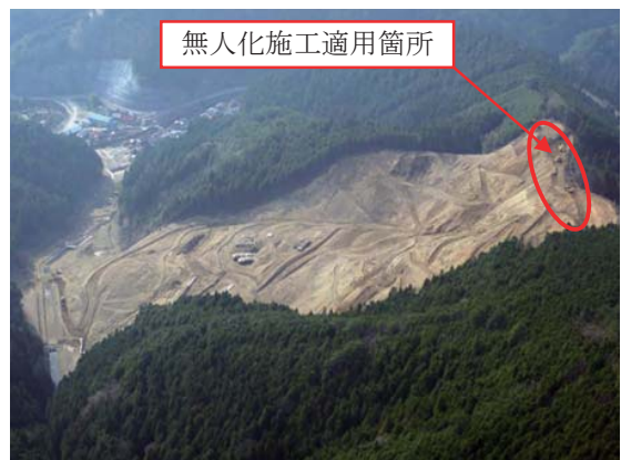
写真-2 北股地区の無人化施工適用箇所 2)
