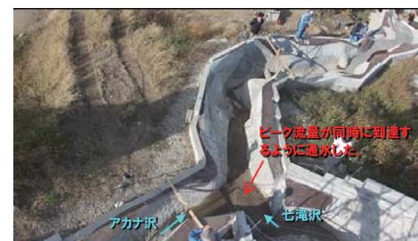
写真-1 天然ダム決壊状況
