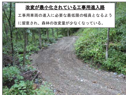
図7 改変が最小化されている工事用進入路
