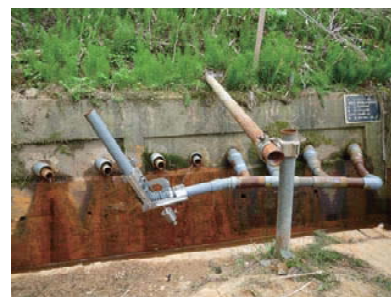
写真-2 集水管閉塞防止器
