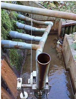
写真-4 集水管閉塞防止器孔口の状況
