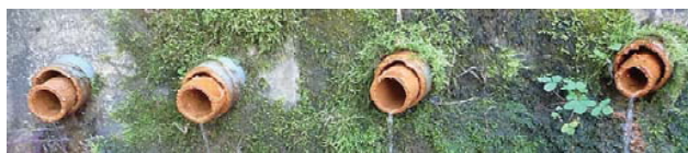
写真-6 閉塞防止器を装着した集水管孔口の状況
