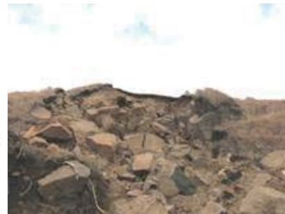
図-3 吉岡地区崩壊斜面状況
