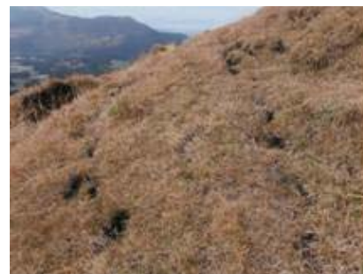
図-4 吉岡地区崩壊箇所周囲の地表面の状況
