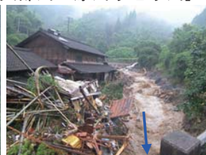
写真-3 土砂流出状況 [うどう川支川下流]
