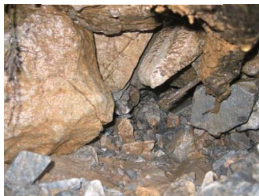
写真—1 パイプ孔内部
