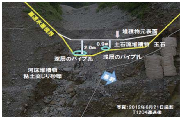
写真－2 パイプ流発生箇所と溪床横断面崩落地
