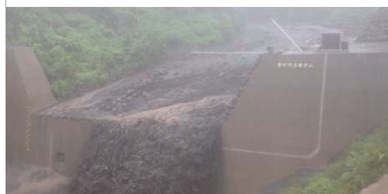
写真-3 土石流発生状況
