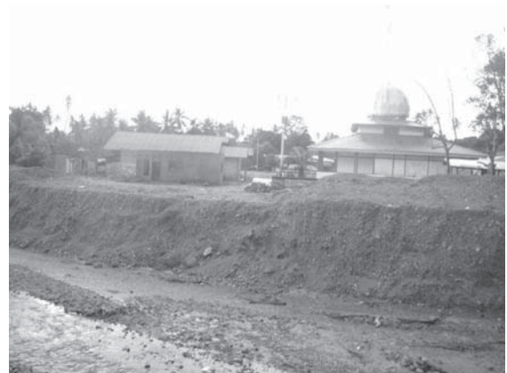
写真-2 マムア川下流での土砂氾濫状況
