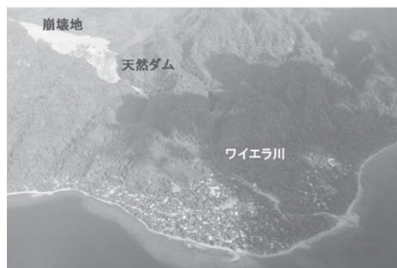
写真-1 ワイエラ川の崩壊地と天然ダム、下流集落の状況
