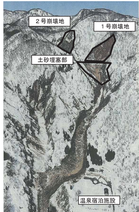
写真-1 中条川被災箇所全景 (信濃毎日新聞 3.13 記事より)
