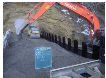
写真-4 INSEM 材敷均し状況
