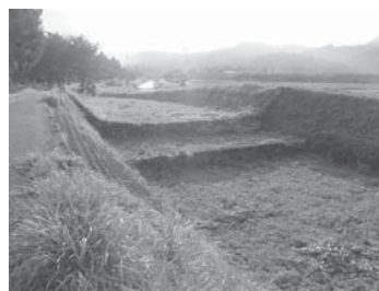
図-4(左上) 鎌倉沢川の床固工と護岸工(昭和11年撮影)
