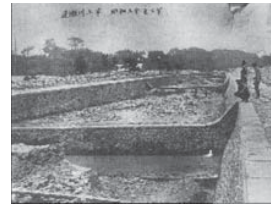
図-4(左上) 鎌倉沢川の床固工と護岸工(昭和11年撮影)
