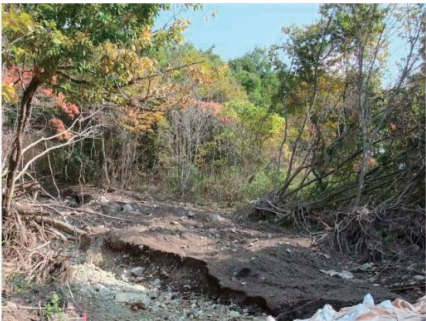
写真-1 土石流流路の状況
