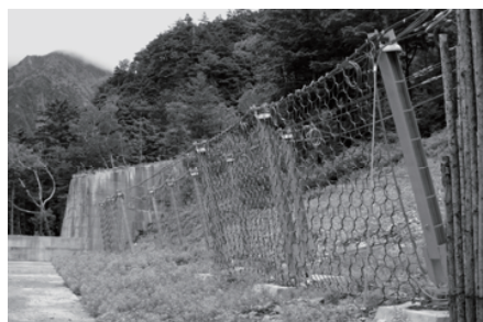
写真-2 五千尺沢 TAMPO バリアの全景
