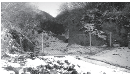
写真-4 木挽崩沢 TAMPO バリアの全景
