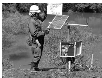
写真2 水位計(観測装置)の設置状況
