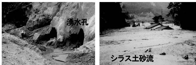
写真2.1 旧吉田町におけるパイピング孔(左)と下流域でシラス土砂流により埋没した家屋(右)
