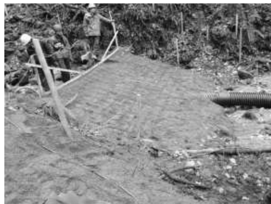
〈実験②の天然ダム〉
