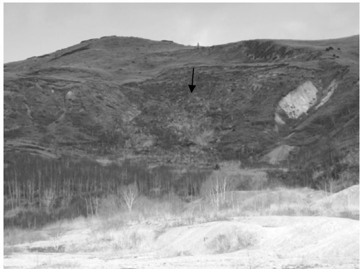
写真-1 昭和12年に崩壊した斜面
