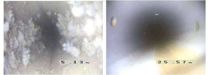
写真-2 集水管内の状況
