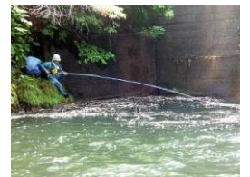
写真1 砂防えん堤基礎部の撮影風景
