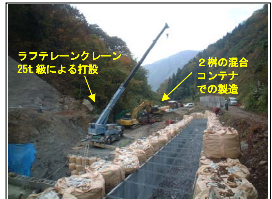
図3 第二堰堤下流面の施工機械配置状況
